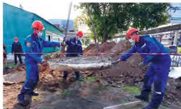
Работники участка водоснабжения и канализации обновляют канализационный колодец
