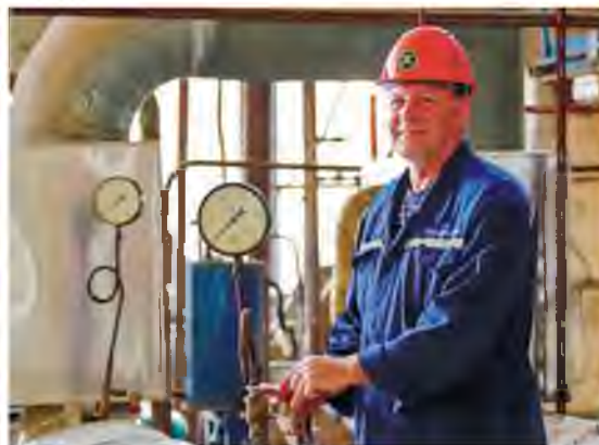
Слесарь Михаил Ясков заменяет манометр на паропроводе
