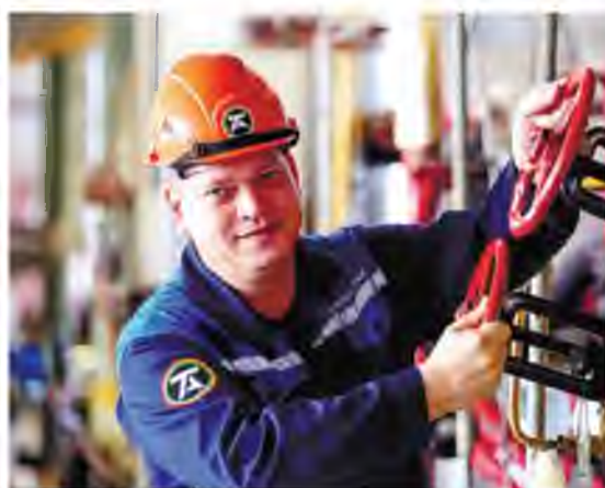
Оператор котельной Артём Орешкин занят пробным розжигом котла
